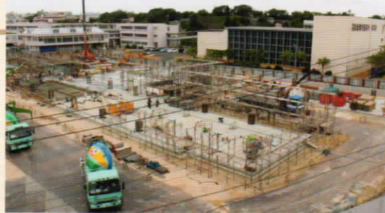
新校舎建築現場(H27.4.24現在)
